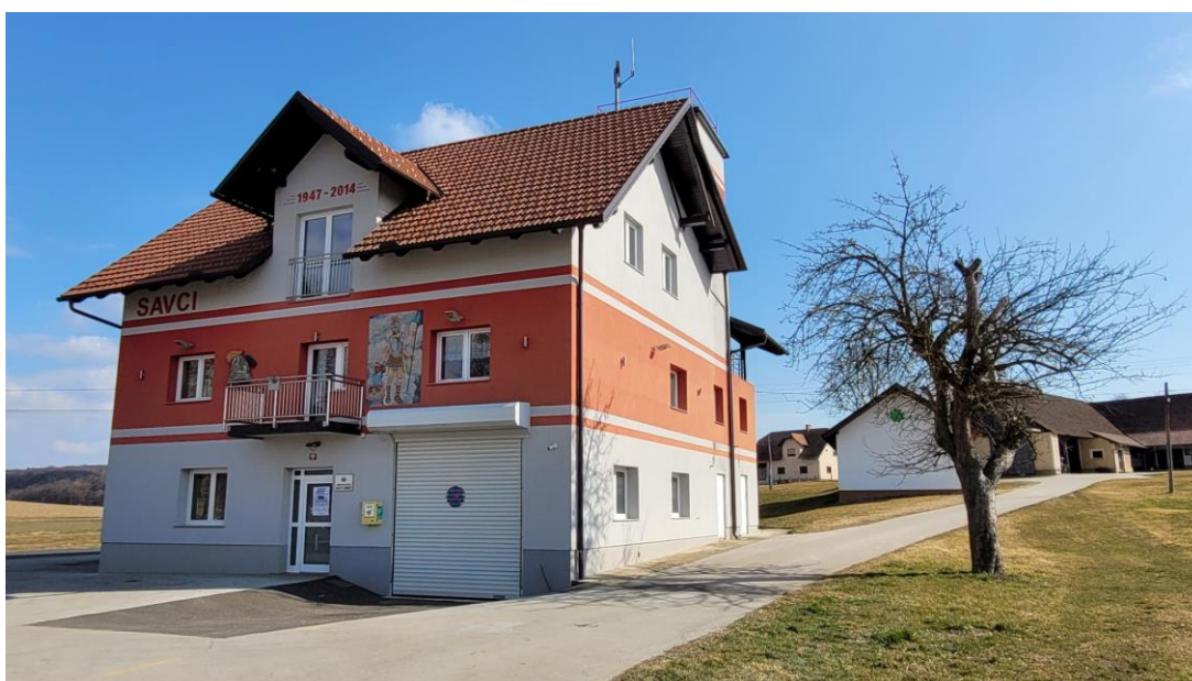
Slika 3.10: Gasilski dom Savci.
