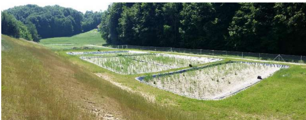
Slika 2: Rastlinska čistilna naprava 7
